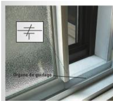
Figure 23 Le guidage en translation d'une fenêtre
