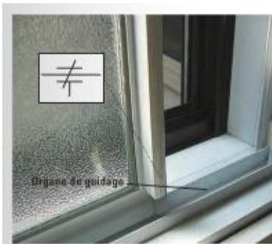
Figure 23 Le guidage en translation d'une fenêtre
